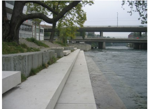
Wipkingerpark. Flusssufer mit Sitzstufen aus Beton.
