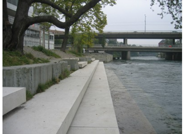
Wipkingerpark. Flusssufer mit Sitzstufen aus Beton.
