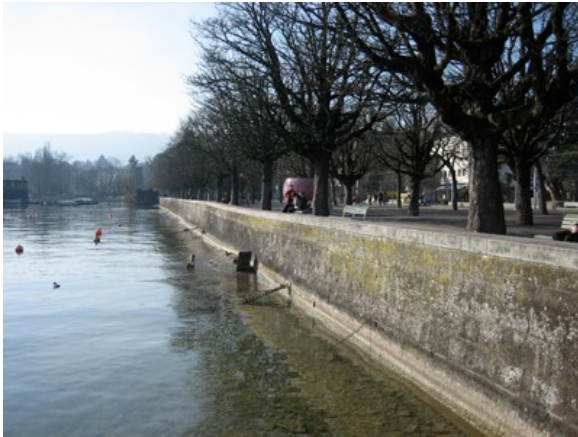
General-Guisan-Quai. Vertikales Seeufer, Abschluss mit Stützmauer.
