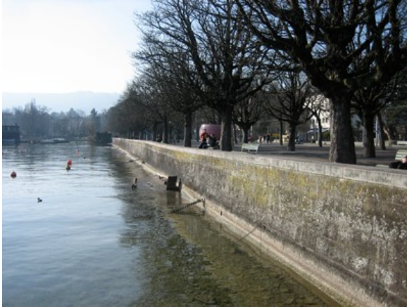
General-Guisan-Quai. Vertikales Seeufer, Abschluss mit Stützmauer.
